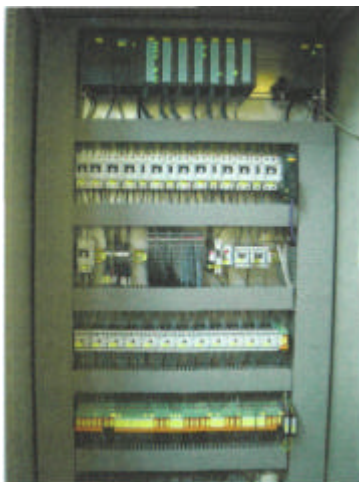
Kontrol- kaj komandoĉelo, transformilo por 110 kV (Chitila)
