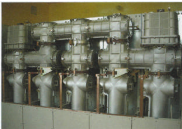
Transformĉeloj por 25 kV
