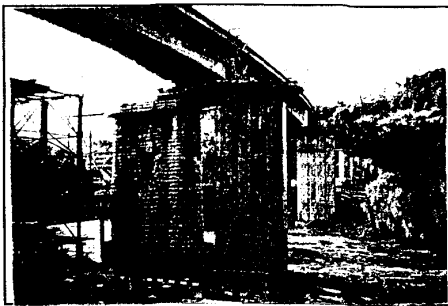
La finkonstruita betonponto duonvoje ŝovita de la help-pilieroj al la malnovaj pilieroj
