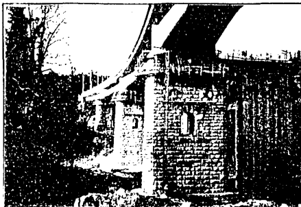
La nova betonponto atingis la definitivon pozicion sur la 120jaraĝaj ponto-pilieroj.
